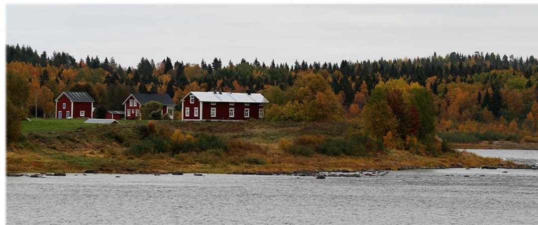
Det gamla byggnadsbeståndet i Korpikylä.
