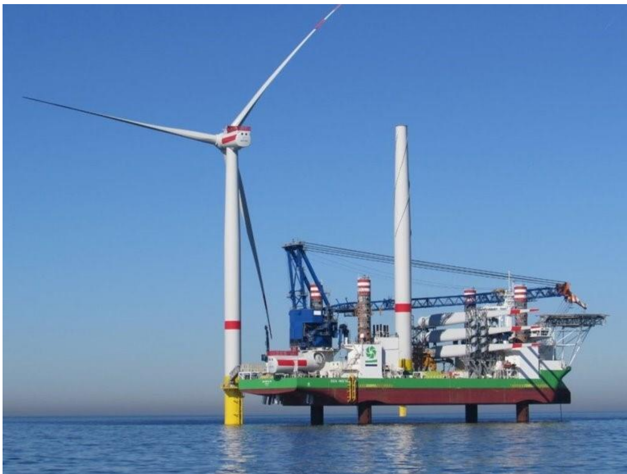
Figur 15. Montering av vindkraftverk med ett fartyg av typen jack-up. Källa: COWI
