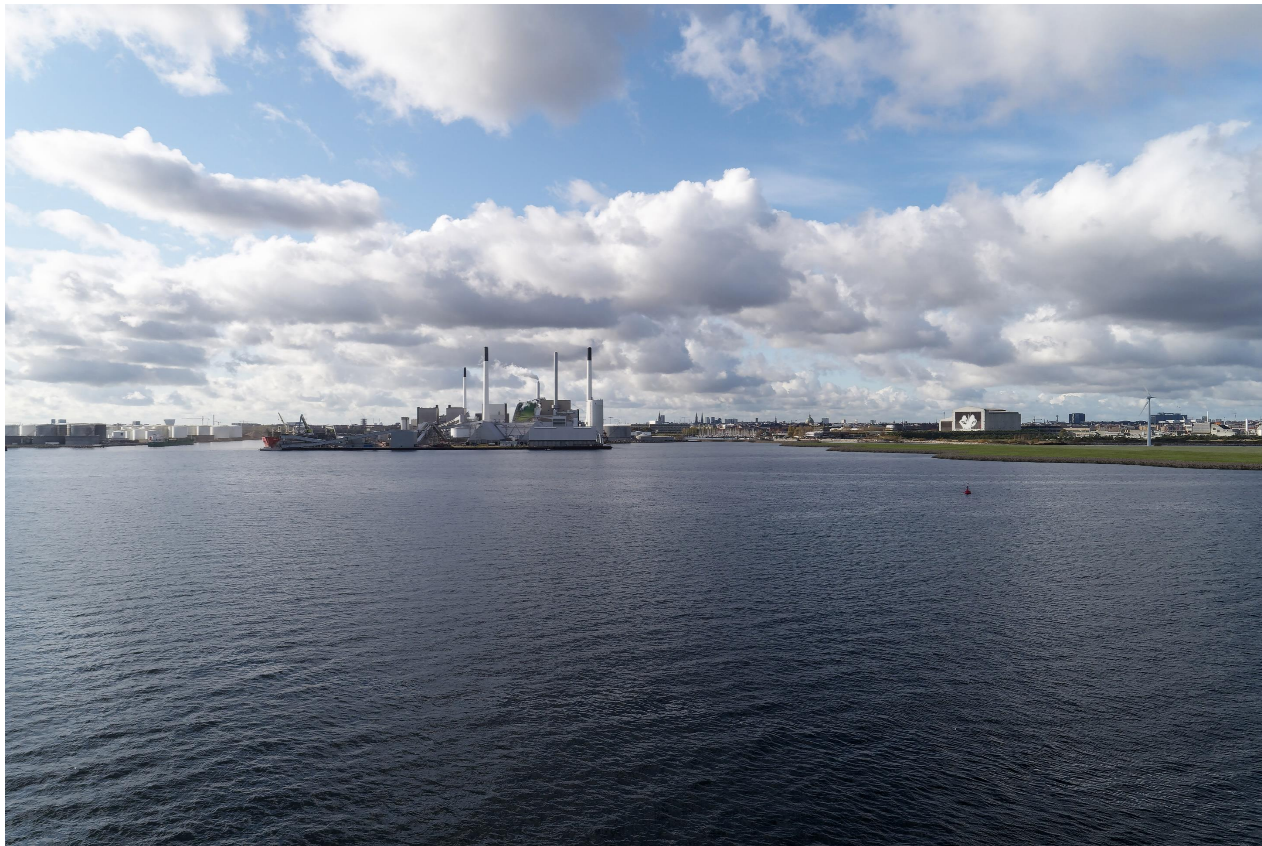
Figur 13 Fotostandpunkt 4 vest-sydvest – 0-alternativ set fra Øresund øst for Lynetteholm. 0-alternativet viser udsynet fra fotostandpunktet hvis planen ikke gennemføres. Lynetteholm er vist i kote 4, jordtransportvejen som etableres mellem Quintus og Refshaleøen, i forbindelse med opfyldet af Lynetteholm fremgår af 0-alternativet.
