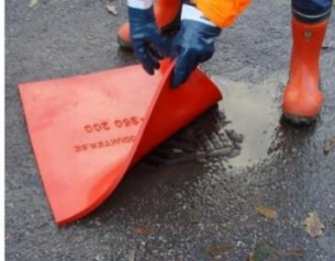
Fig. 5. Exempel på brunnstätning liknande de som används i Brunna.
