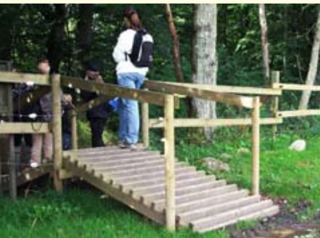
Den upphöjda gångristen kan vara en lösning om marken inte går att gräva i. Gångristen har ofta trä mot mark och den nedre spjälkan går fort sönder, som på denna cirka två år gamla anordning. Lägg märke till leran vid insteget.
