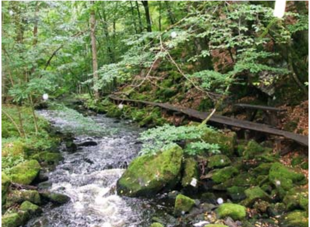
En känsligt placerad plankspång i Söderåsens nationalpark underlättar passagen av ett stenigt parti. Spångens lärkplank oljas årligen för att minska halkrisk och förlänga livslängden.
