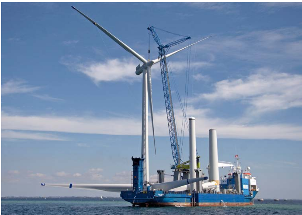
Bild 6. Installation av vindkraftverk vid Lillgrund (foto: Hans Blomberg/Vattenfall).
