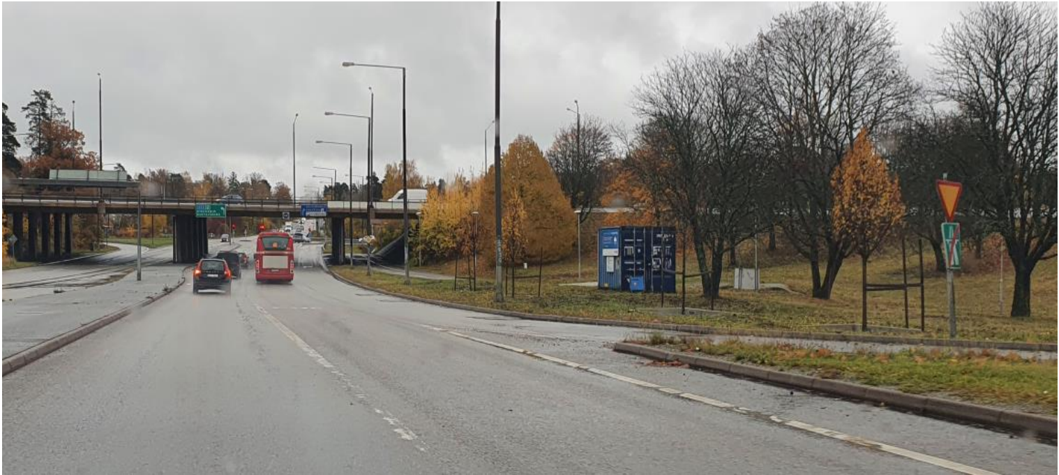
Figur 42 Hjulspår och asfaltsyta Värmdövägen sett österut med regnbäddarna till höger i bild.
