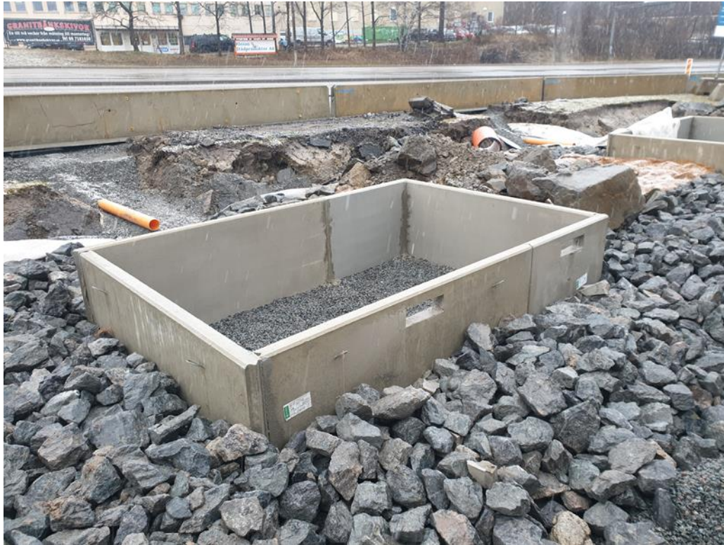
Figur 8 Anläggning under konstruktion. Substrat i regnbädden och skärv runt om.
