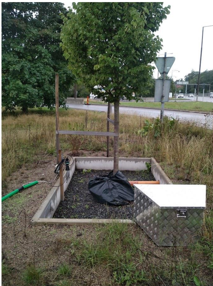
Figur 16 Mätning flöde, inlopp. Översiktsbild med låda för teknisk utrustning.
