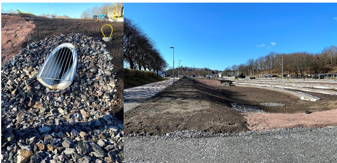
Bild: 9 & 10 Galler sätts dit vid inkommande trafikdagvatten, se Figur 3. Raingarden sett söderut, plantering är ännu ej utförd på ytorna men ska utföras i detta projekt.
