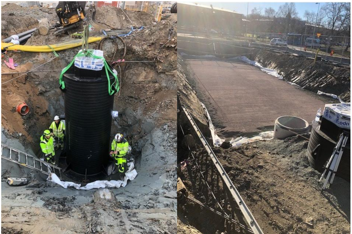
Bild:5 & 6 Filterbrunn med en djup schakt och ditsättning samt resultat efteråt ovanpå Kassettmagasin när kringfyllnad är utförd.
