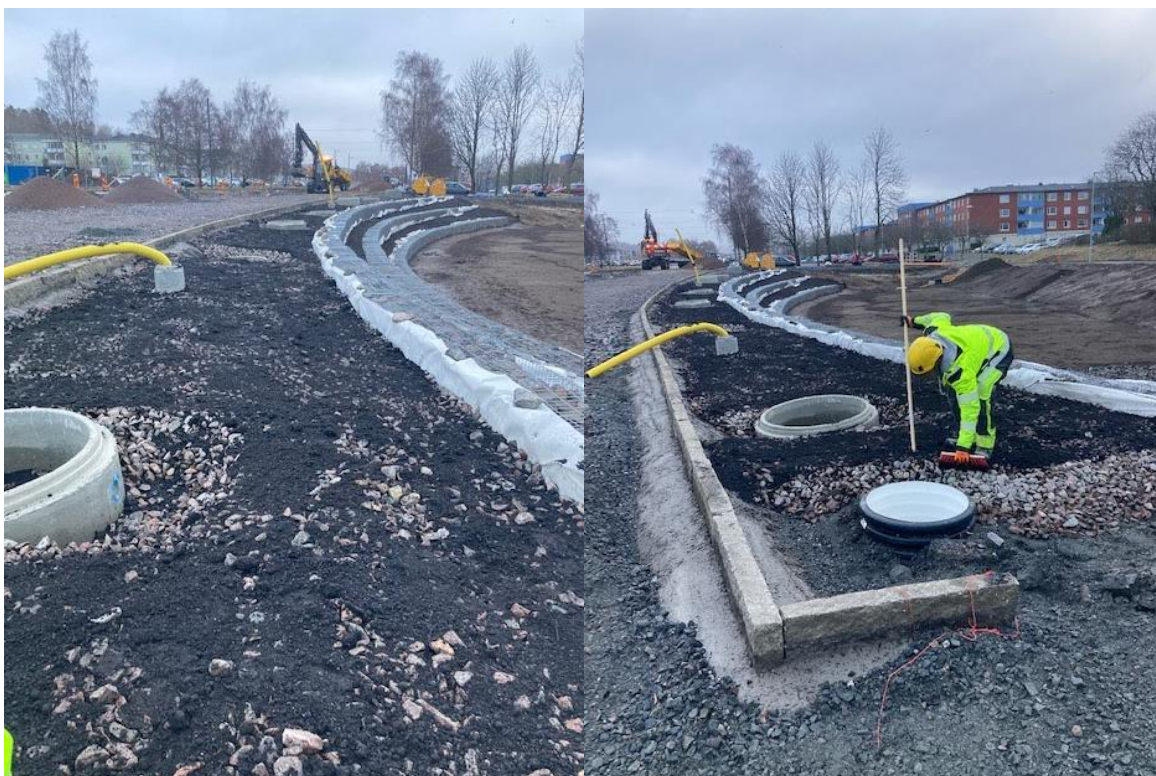
Bild:7 & 8 Växtbäddar med särskild näringsberikad biokol vid Raingarden ytan sett norrut.
