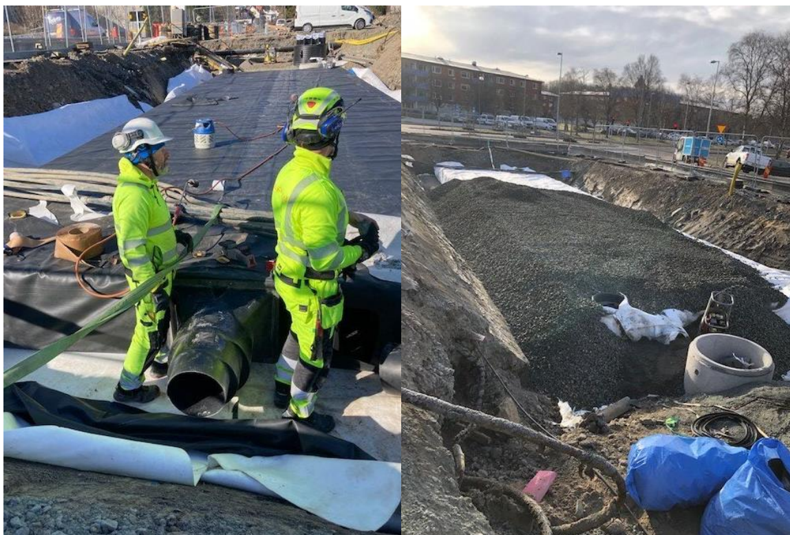
Bild: 3 & 4 Gummiduk och grus läggs på kassettmagasin vid byggnation.
