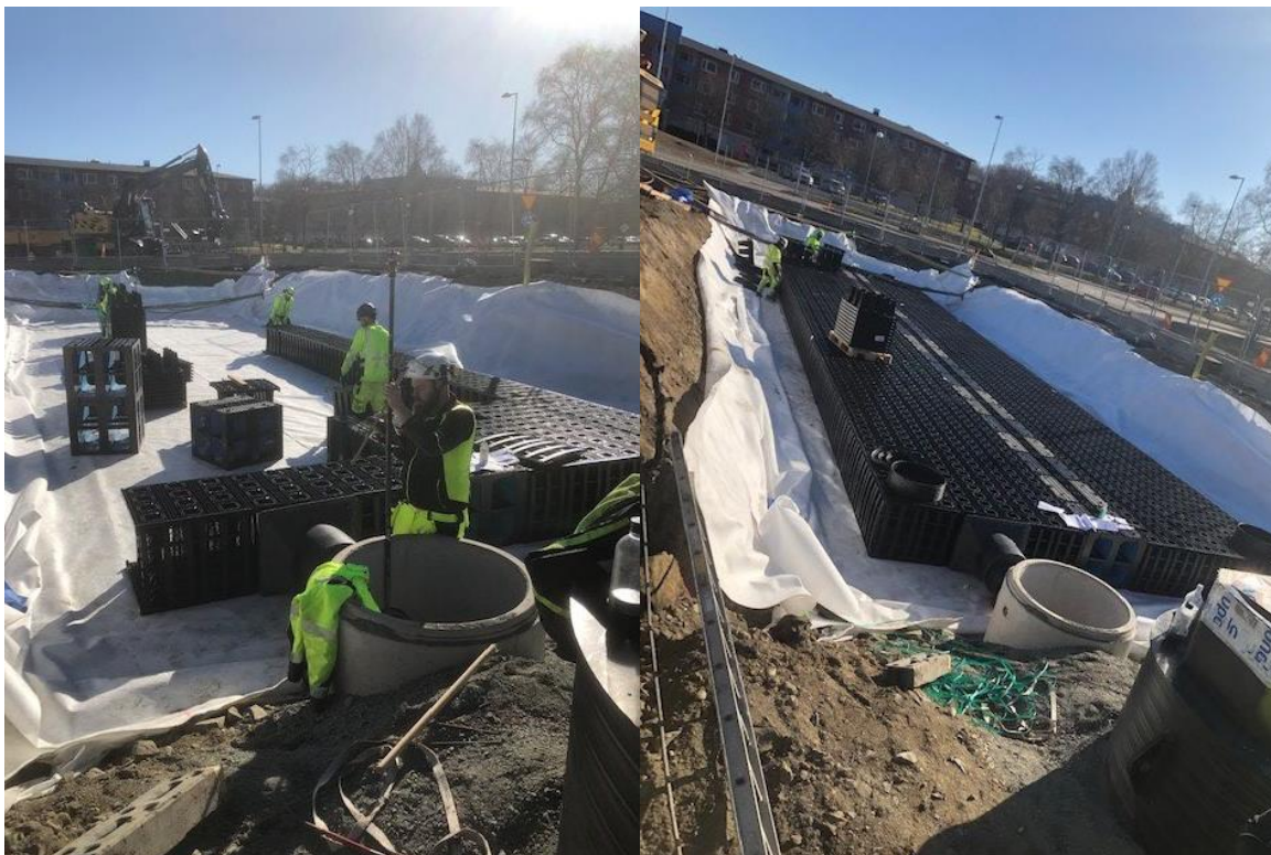
Bild: 1 & 2 Kassettmagasin under montering vid byggnation.
