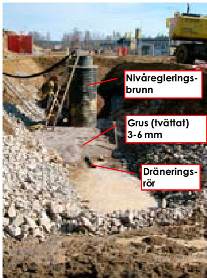
Figur 8. Pågående anläggning av uppsamlingsanordning inom gruvområdet. Foto: Åsa Hanæus.
