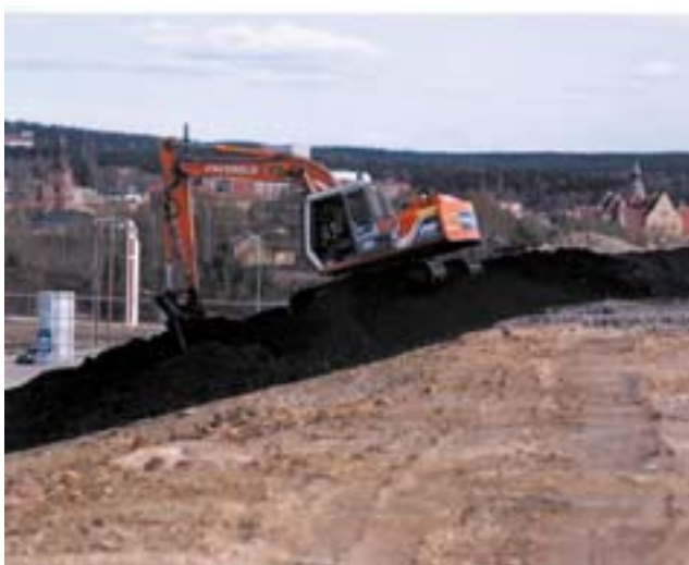
Figur 6. Utläggning av tätskikt på Ingarvsmagasinet.
