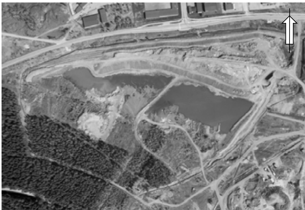
Figur 9. Flygbild från 1983 över Ingarvsmagasinet vid anläggning och idrifttagande. © Lantmäteriet Gävle 2010. Medgivande 75986229
