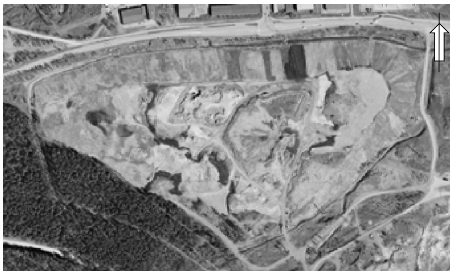
Figur 16. Ingarvsmagasinet under pågående sluttäckningsarbeten 2002. © Lantmäteriet Gävle 2010. Medgivande 75986229
