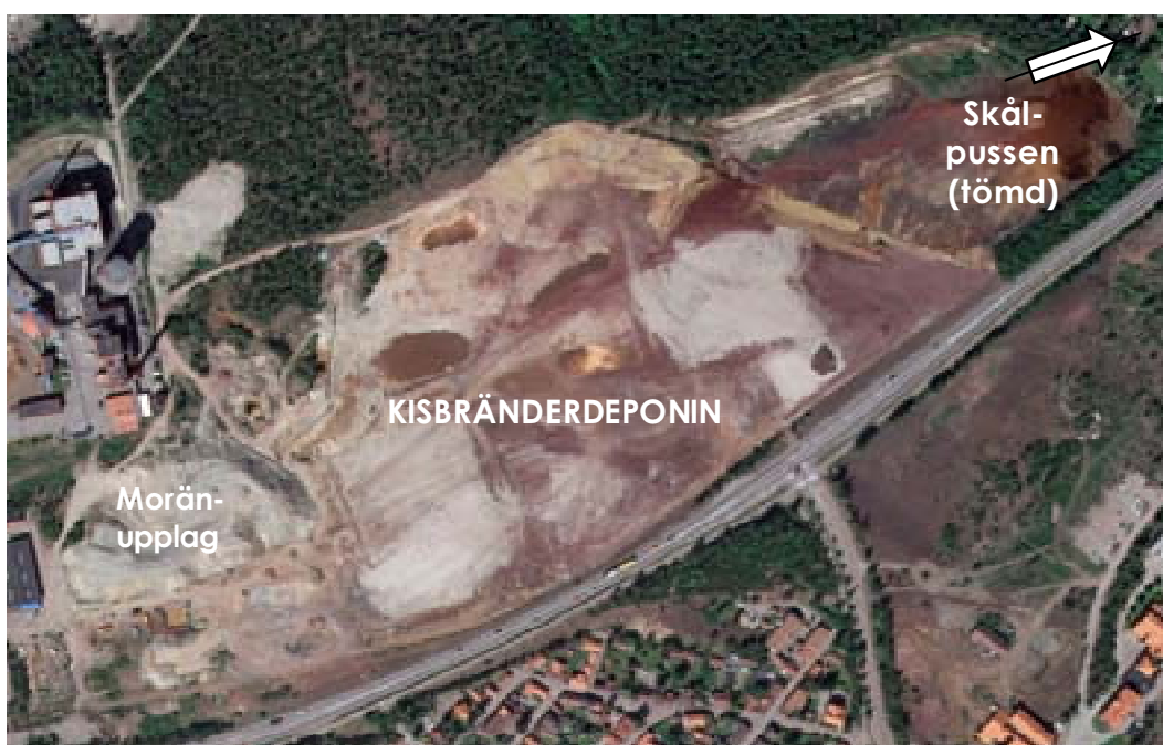
Figur 51. Kisbränderdeponin under pågående terrasseringsarbeten, 2007. Till vänster i bilden syns upplaget av morän (sluttäckningsmassor) och till höger syns Skålpussen där vattennivån sänktes 0,5 m för att öka bärigheten inför påförandet av sluttäckningsmassor. © Lantmäteriet Gävle 2010. Medgivande 75986229
