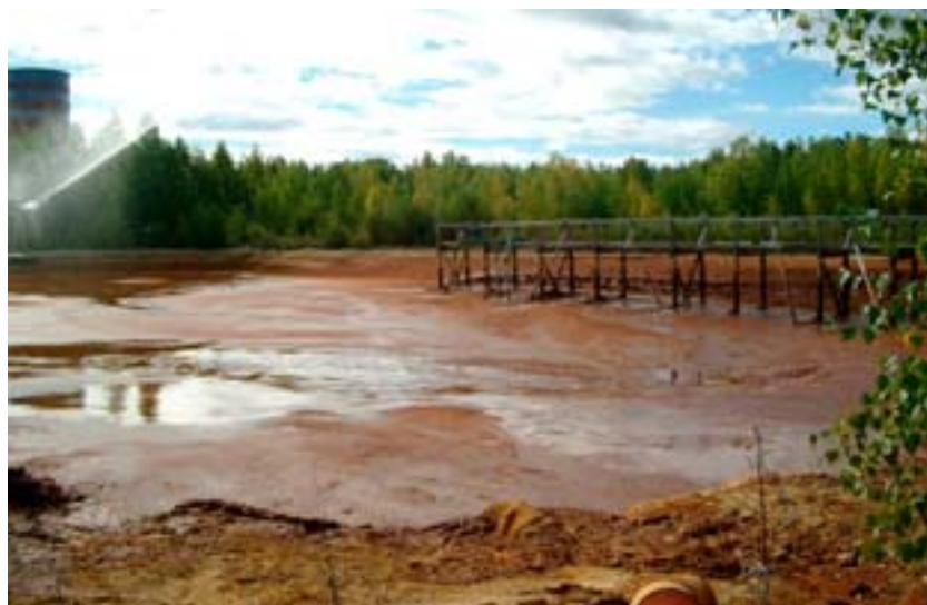
Figur 44. Sedimenteringsbassäng i samband med tömning för urpumpning av slam.
