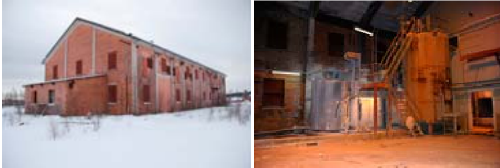
Figur 56. Byggnaden som revs i samband med sluttäckning av kisbränderdeponin 2007. Till höger nedmontering av processutrustning för kalkfällning.
