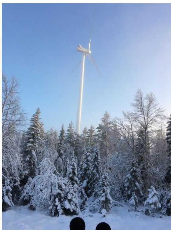
Figur 18 Bild från inspelningsplats, Omgivningen karakteriserades av den kalla och snöklädda omgivningen.
