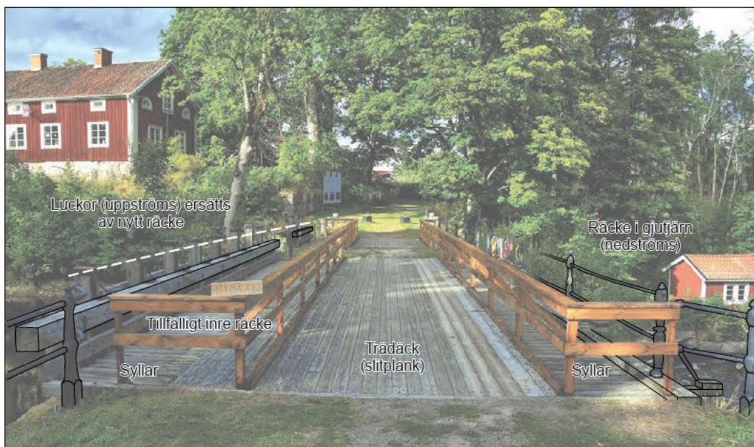
Figur 13. Tillfälligt inre räcke på bron över Järledammen. Augusti, 2020. Foto: Peter Lidman.
