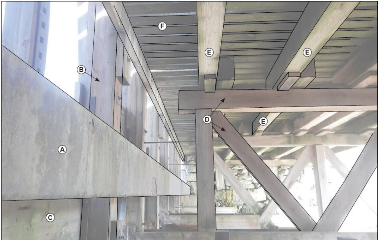
Figur 9. Sekundärbalkar (E) skarvade i omlott och mellanstöd (D) uppbyggt som fackverkskonstruktion. Bröstbalk (A), gåtbalkar (B) och luckor (C) till vänster i bild. Syllar (F) som bär upp slitplankor (vägbanan). Fotografi från lucka 1 och 2, vy mot norr. Strömningsriktning till höger i bild. Från WSP (2019).
