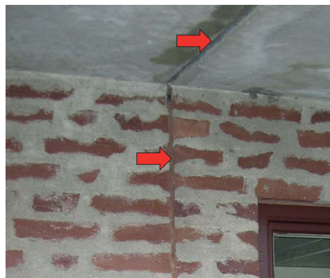
Fogmassa i dilatationsfog (rörelsefog) i tegelvägg och loftgång
