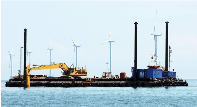
Figur 3-3 Flydende pram med hydraulisk grab/skovel (backhoe/gravemaskine)
