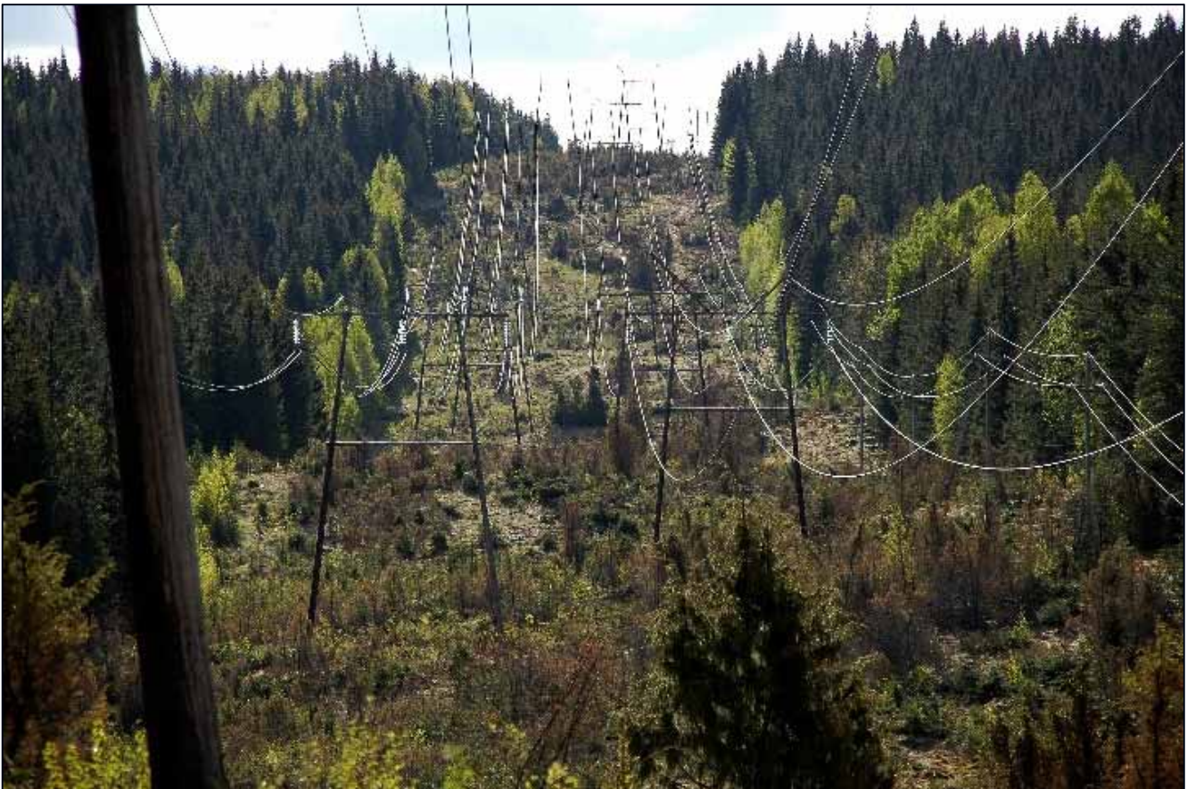
Kuva 11. Esimerkki valikoivasta raivauksesta.
