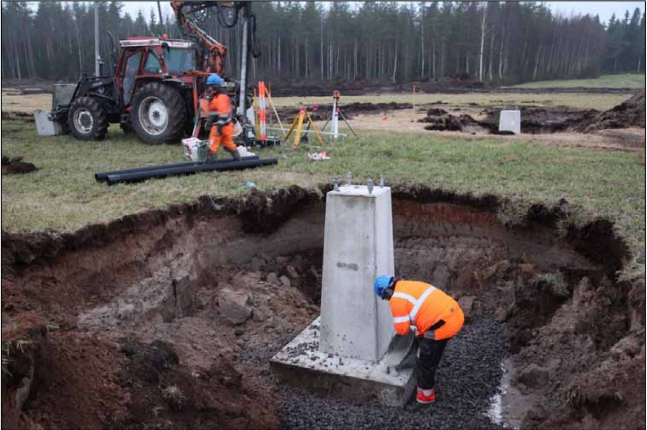
Kuva 8. Pylvään perustuselementin asentaminen.
