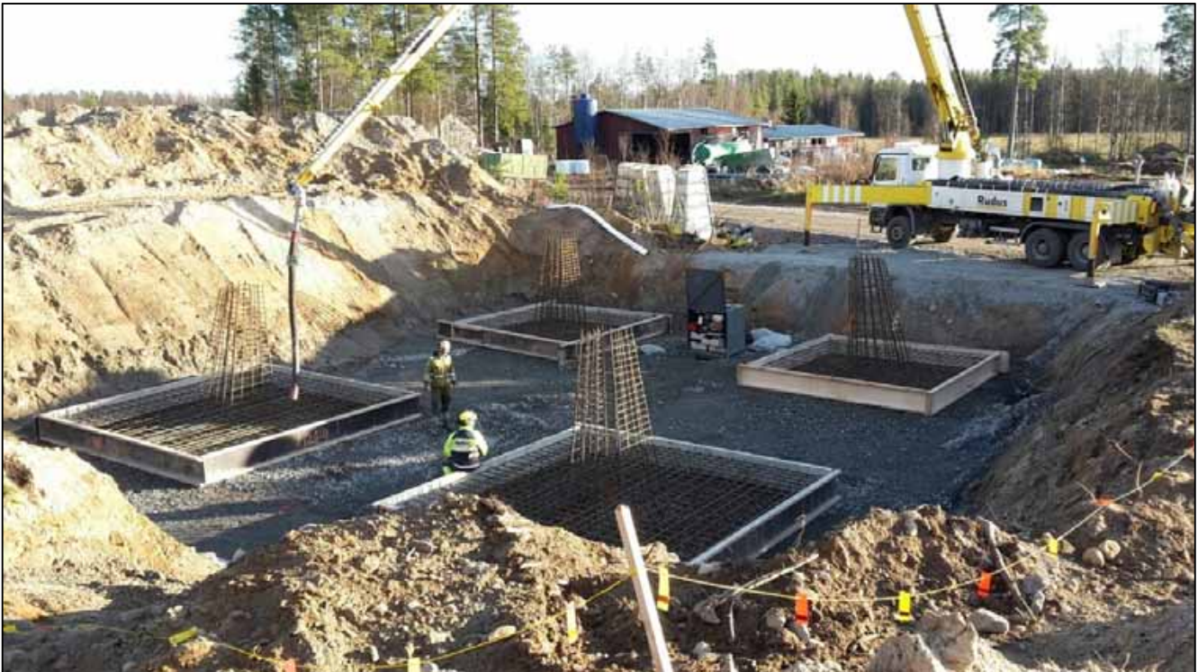
Kuva 9. Vapaasti seisovan pylvään perustuksen pohjatöitä.
