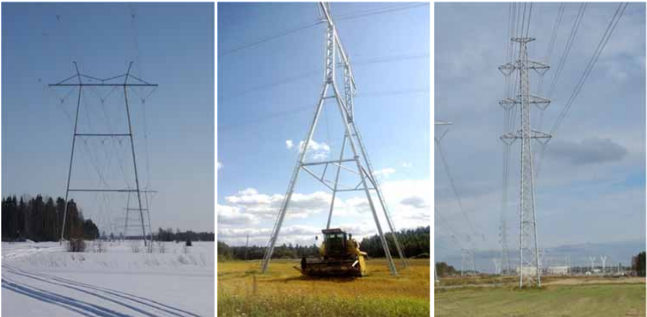
Kuva 20. Esimerkkejä eri pylvästyypeistä. Vasemmalla 400+110 kilovoltin haruksin tuettu teräksestä valmistettu portaalipylväs, keskellä vapaasti seisova harukseton peltopylväs ja oikealla vapaasti seisova t-pylväs.
