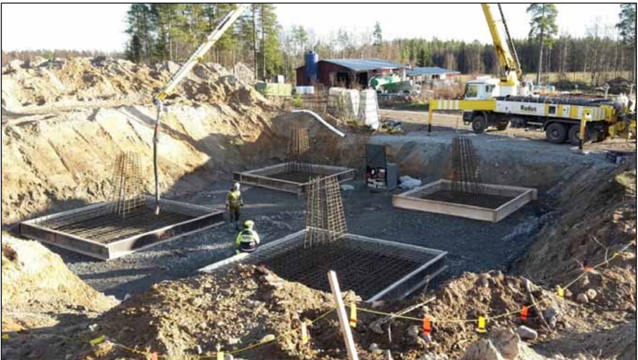
Kuva 10. Vapaasti seisovan pylvään perustuksen pohjatöitä.
