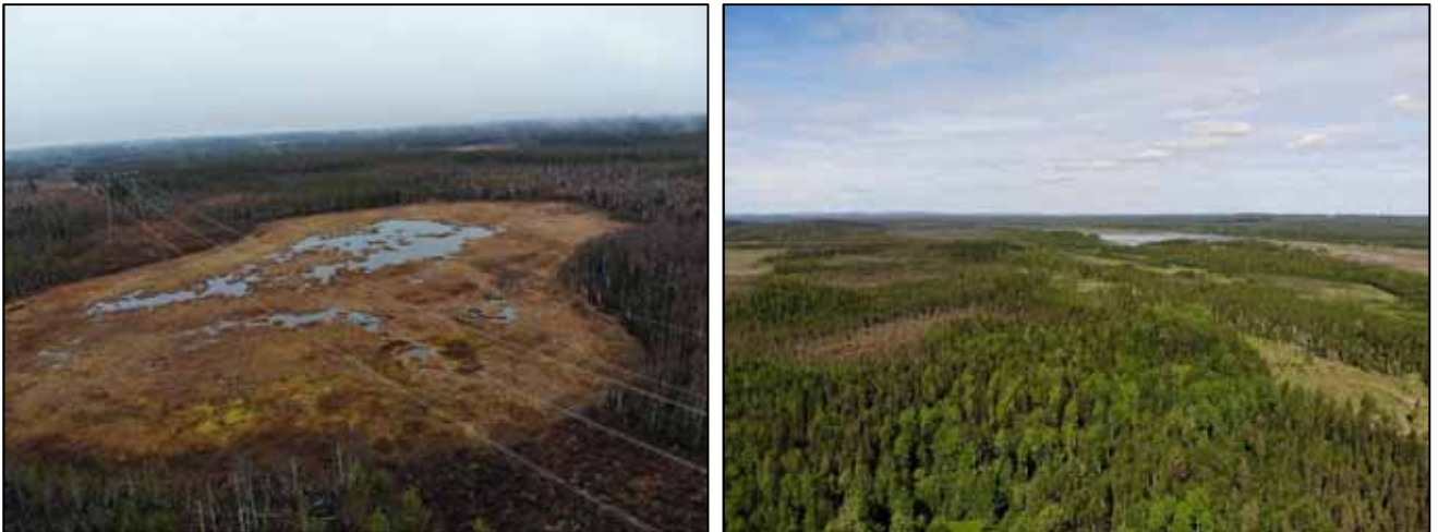
Kuva 73. Pihtijärvi on umpeenkasvanut, luhtainen kosteikko. Hurujärven alueella voimajohto sijoittuu nuoriin talousmetsiin ja pääasiassa puustoisille soille.
