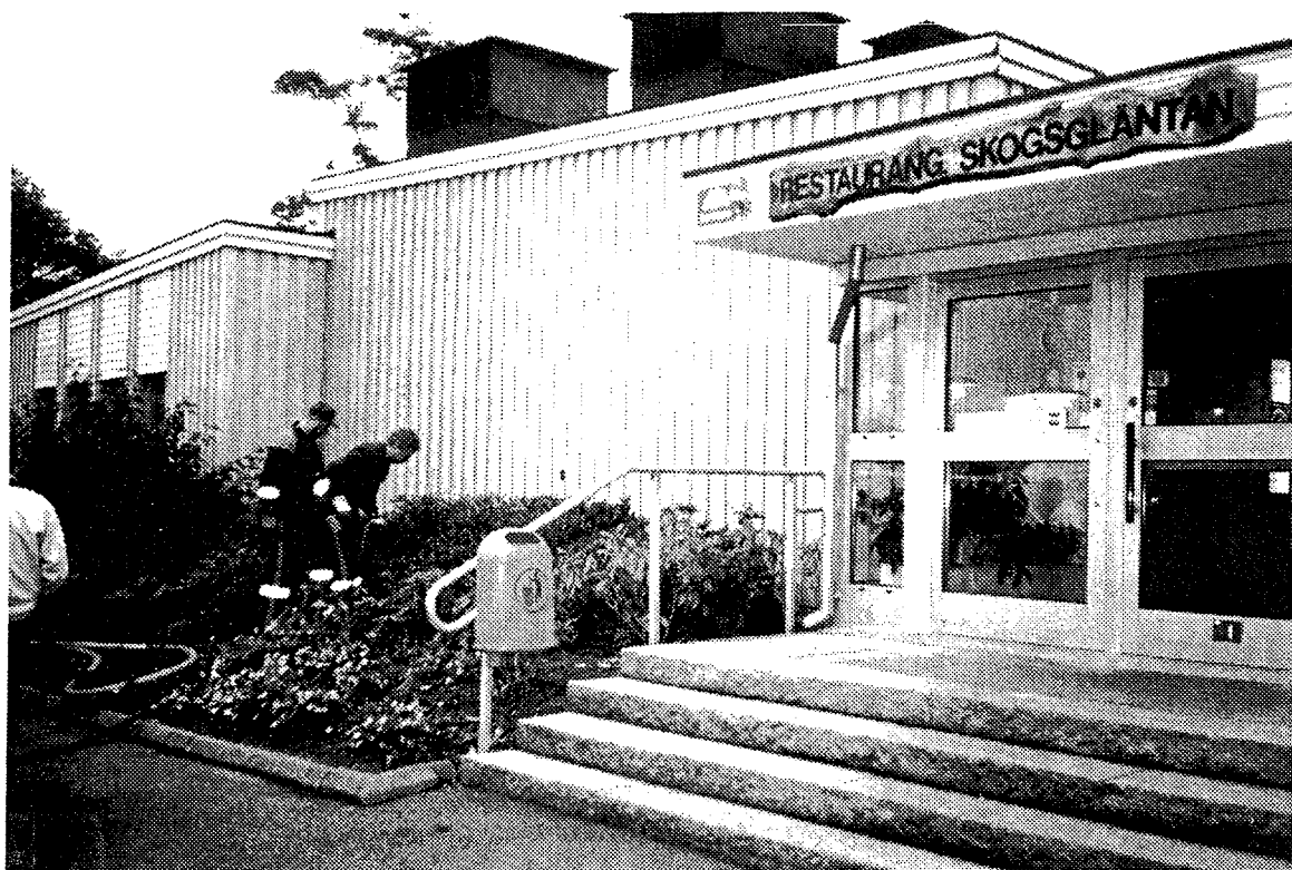
Bild 4 Renspolning av fettavskiljare vid restaurang Skogsglantan på Volvo i Göteborg Färskvattenprov togs två dygn senare från en tappkran i samma byggnad som köket.
