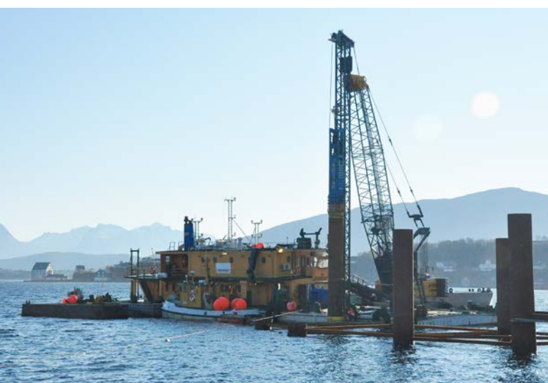
Figur 7 Vänster, pålning av en hamnstruktur i en hamn i Ålseund, Norge (Foto: Mathias Andersson, FOI). Höger, ett pålningsfartyg i den tyska Nordsjön som förberedde en pålning av ett havsbaserat vindkraftsfundament (Foto: Markus Linné, FOI).
