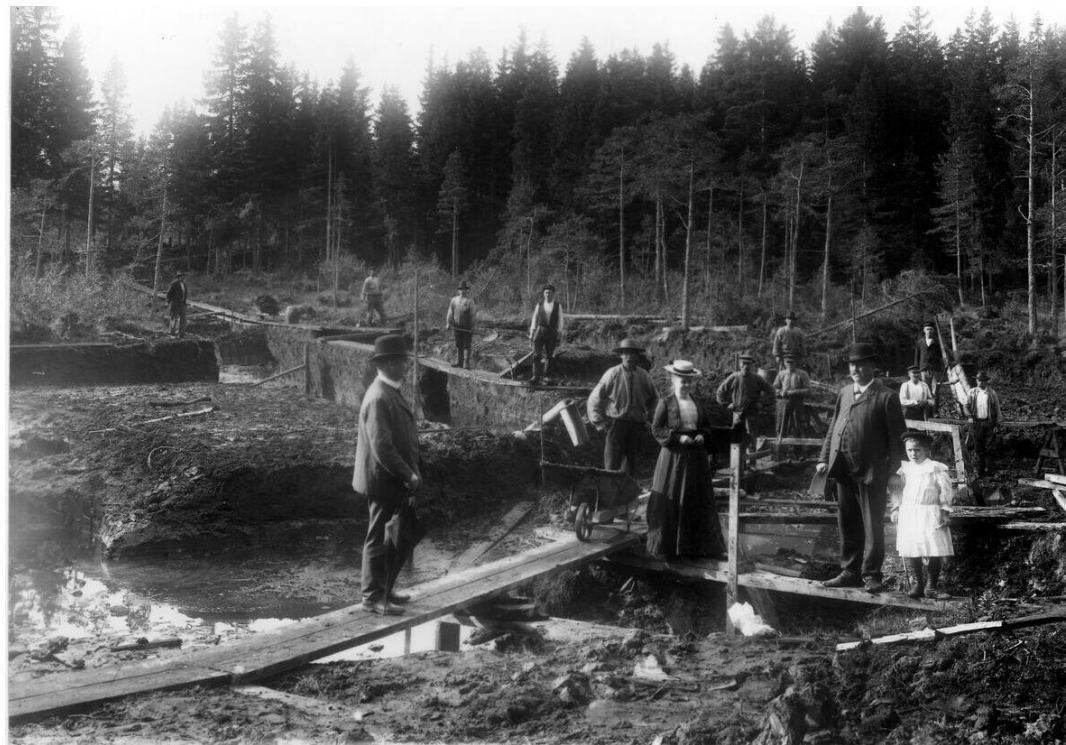
Grundgrävning inför trolig utdikning omkring år 1900.
