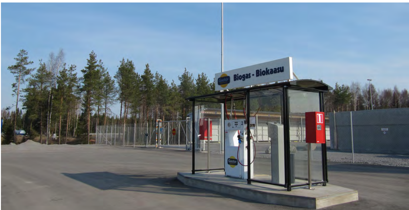
Stormossens biogastankningsstation. Foto: Gustav Nygård.
