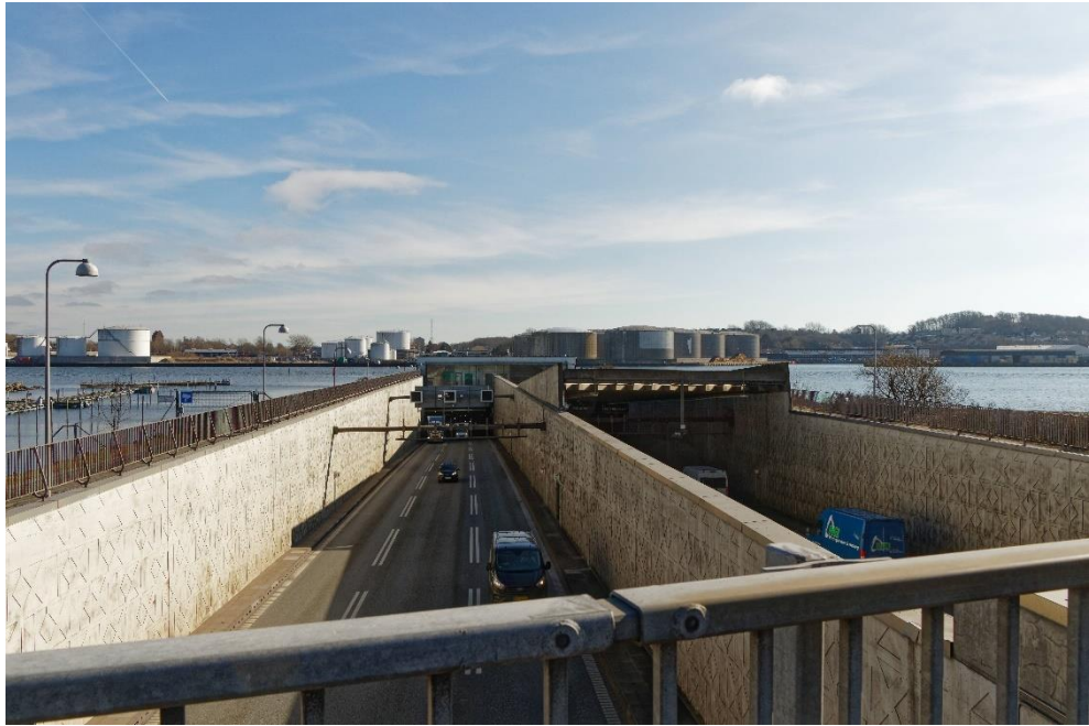
Figur 7.4.11 Eksempel billede for Østlig Ringvej – Billedet er fra Nordjyske Motorvej ved Limfjordstunnelen, set fra Nørresundby siden og er et eksempel på typen af anlæg.
