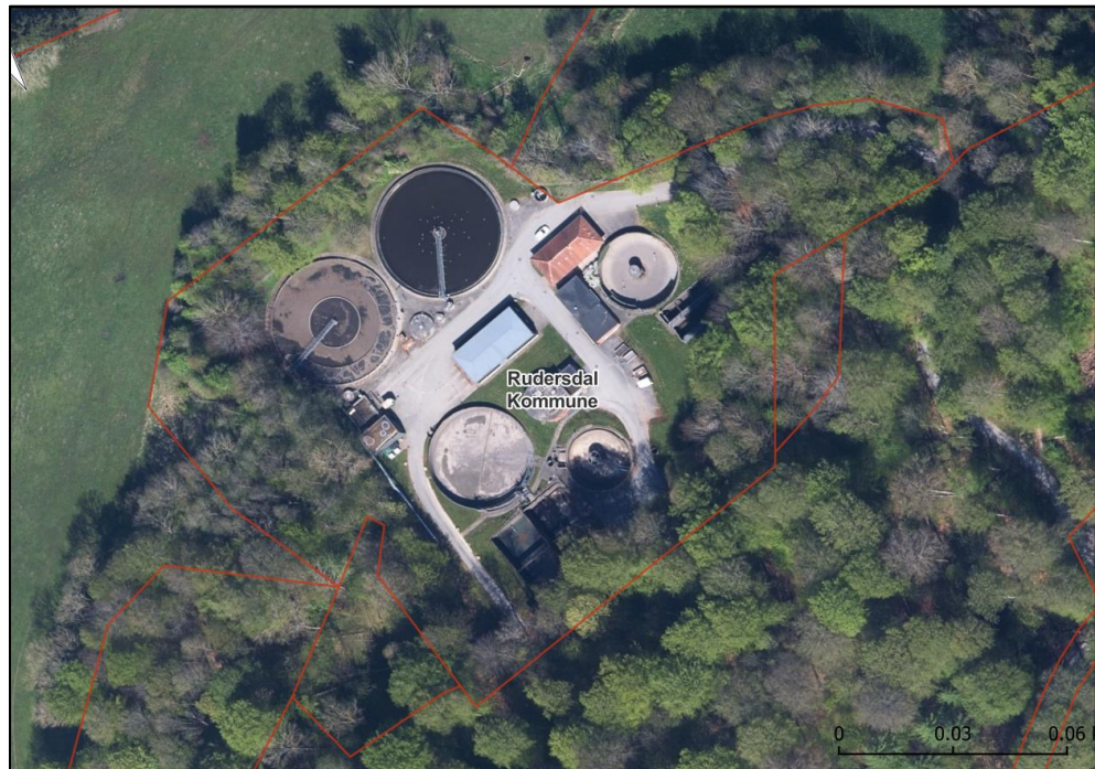
Figur 18-1 Sjælsø Renseanlæg. Anlægget fylder ca. 2 ha og består af veje, bassiner og driftsbygninger.
