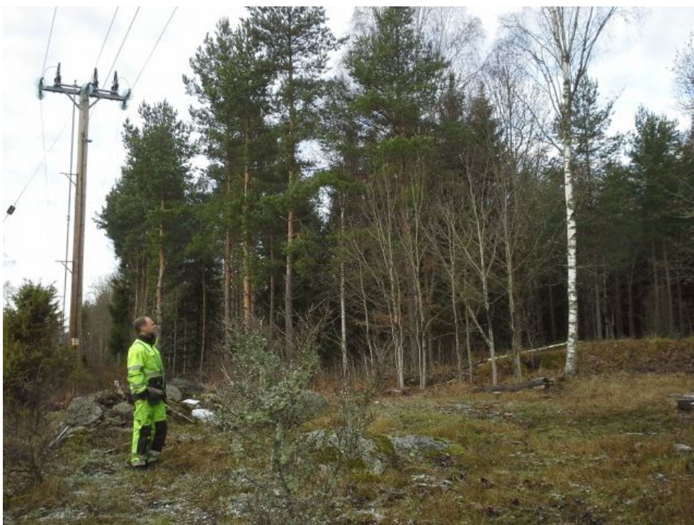
Figur 6. ÅGPs entreprenör röjer fram gläntor och bryn mot skogsmarken intill E.ONs ledningsgata. (Foto: Susanne Forslund)
