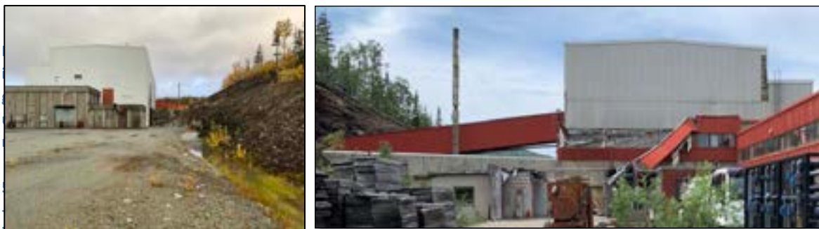
Figur 5-7 Bilder av eksisterende industribygg for oppredningsverket. Bru fra silo i fjellet vises på bildet til høyre.
