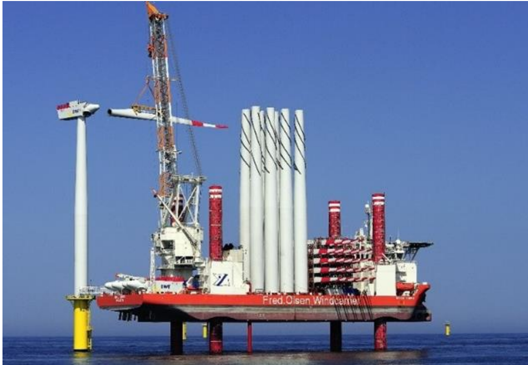
Figur 7.1 Installation av WTG
