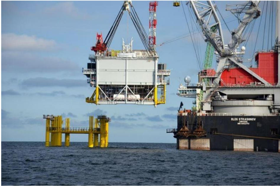
Figur 7.4 Installation av OSS
