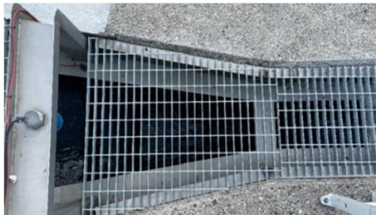
Parshallränna med radarmätning (Källa: VA SYD).
