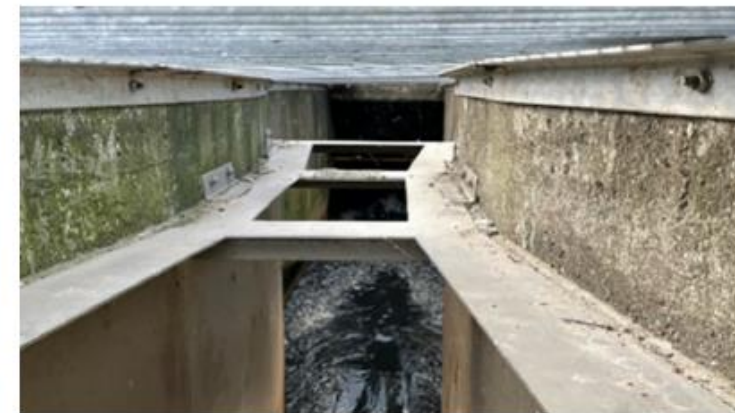
Parshallränna med radarmätning (Källa: VA SYD).
