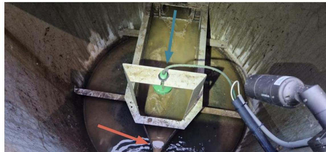
H-ränna med ekolod, vattnets väg markerad med blå pil (Källa: VA SYD).
