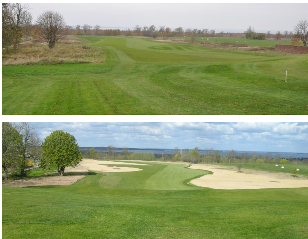
Figur 6. Återskapande av blomrik sandhed på Ekerums golfbana, Öland. Bilden ovan visar en del av golfbanan före åtgärd och bilden nedan visar samma område efter bortgrävning av näringsrika ytjord. Foto: Helena Lager.
