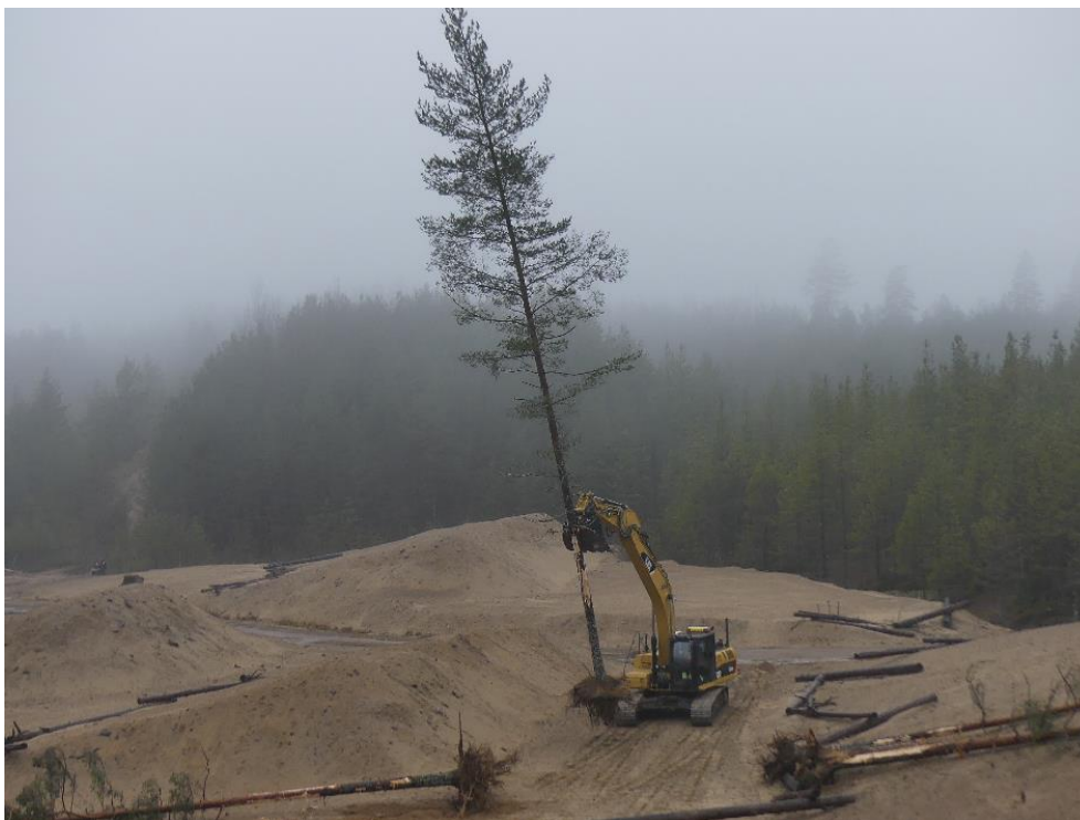
Figur 4. Skapande av sandkullar av överskottsmassor från motorvägsbreddning, i gammal täkt med tidigare flack och igenväxande täktbotten. Värmland, Sörmon. Täkten är en tidigare förekomstlokal för storfibblebi Panurgus banksianus , och åtgärderna innebär återskapande av miljöer för arten och en annan ÅGP-art, sandödla Lacerta agilis . Åtgärderna har genomförts i samverkan med Trafikverket och Karlstad kommun. Foto: Sven-Åke Berglind.
