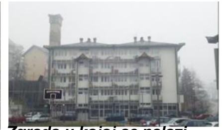
Zgrada u kojoj se nalazi kotlarnica i dimnjak
