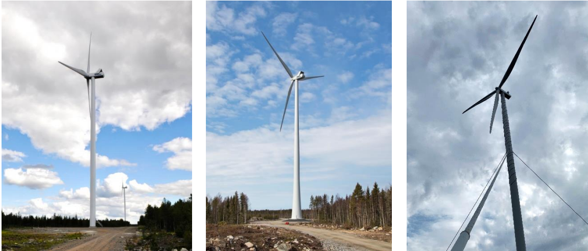
Bild 11. Till vänster är ett exempel på ett stålcylindriskt torn, i mitten ett hybridtorn och till höger ett räfflat torn. (Foton: FCG och Jarkko Finnilä, Carelin)
