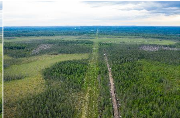
Inom projektområdet finns för närvarande en kraftledning på 400 kV som går i ost-västlig riktning.
