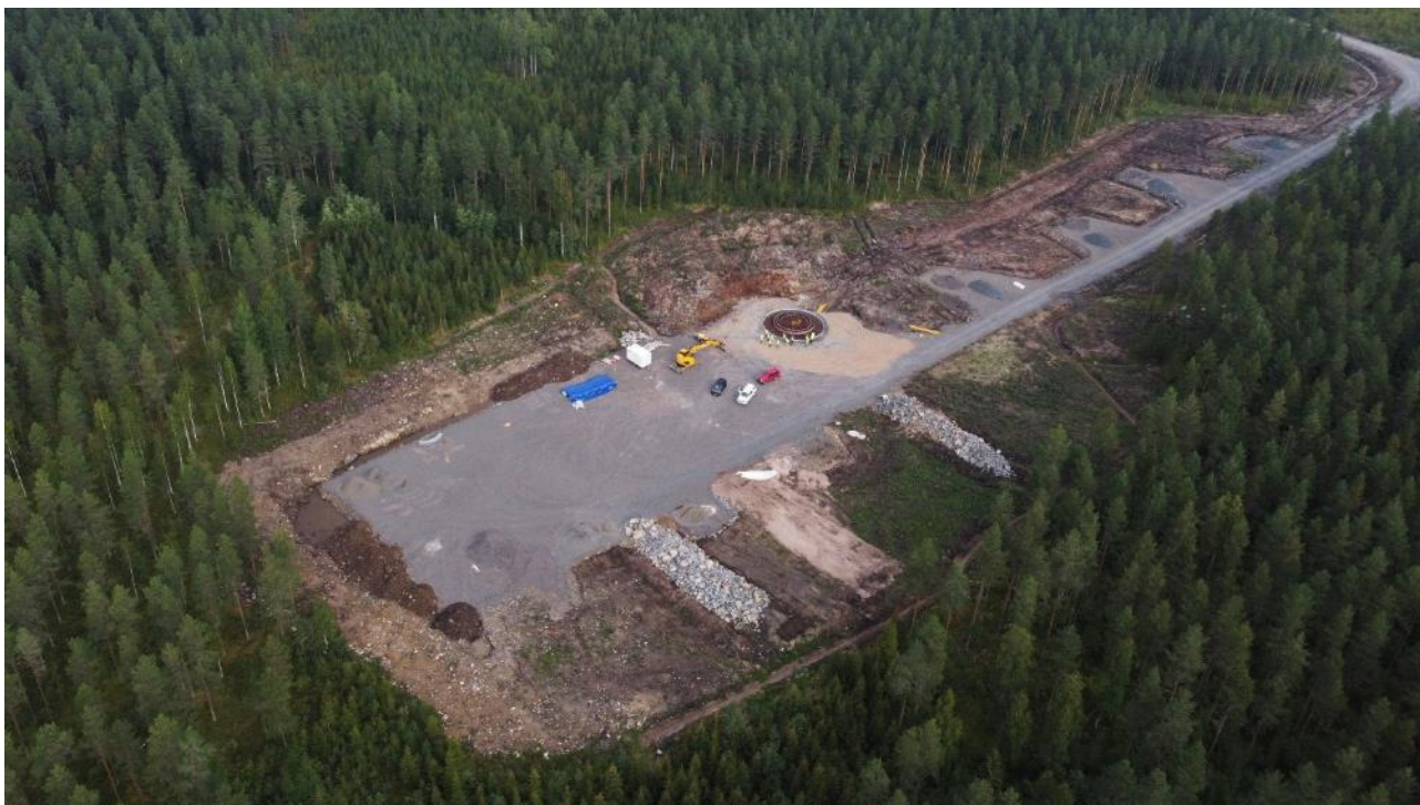
Bild 13. Exempel på monterings- och resningsområde som byggts för ett vindkraftverk och fundament för ett vindkraftverk. Bild: Eolus Energy Oy.
