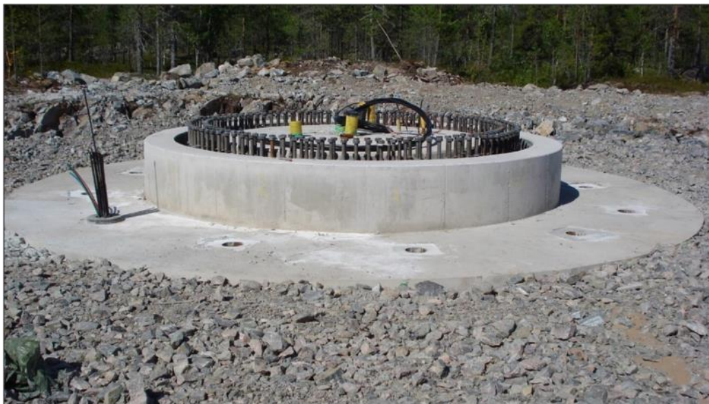
Bild 7. Ett typiskt bergsförankrat stålbetongfundament för ett vindkraftverk. (Bild: YIT)
