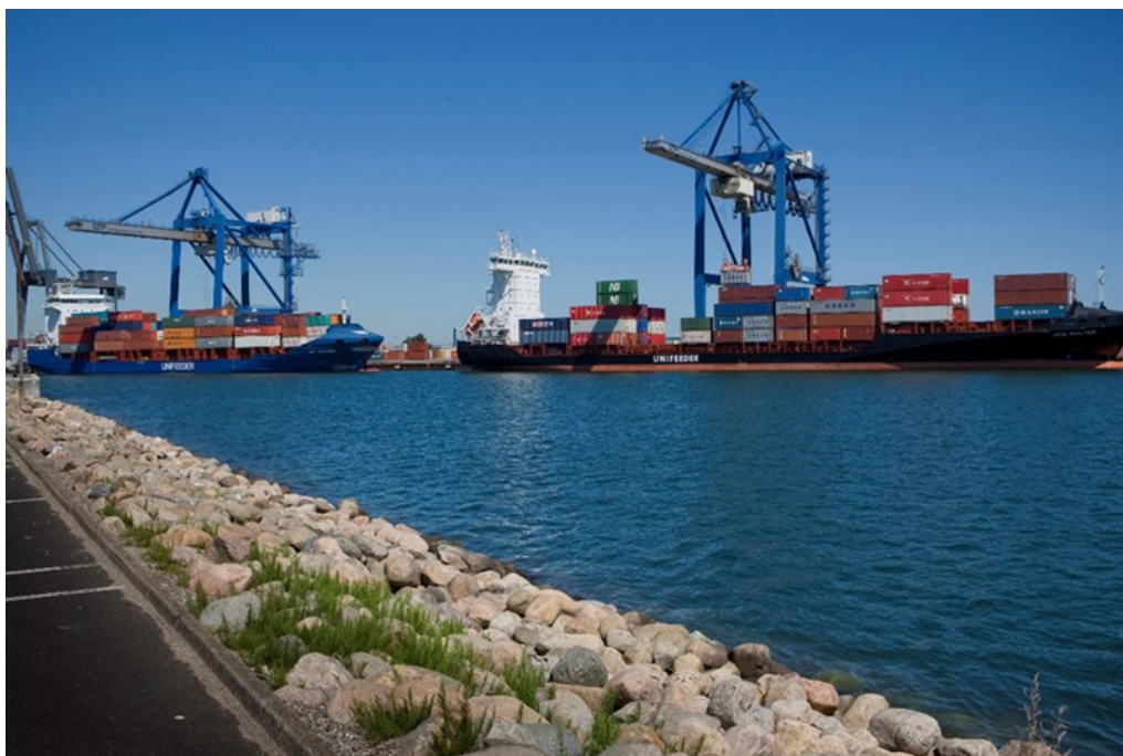
Figur 2: Eksempel på STS-kraner. Her fra den eksisterende containerterminal på Levantkaj i Nordhavn.
